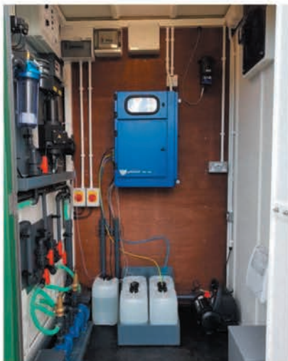
Final Effluent Monitor
